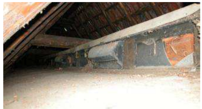
Blick auf die Langseite des Oberlichts mit Fenstern und Lufthutzen.
