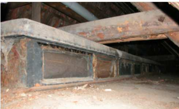
Blick auf die Langseite des Oberlichts. Die Fensterreihe ist nicht unterbrochen, die einzelnen Fenster sind jeweils mit einem Wetterschenkel versehen.
