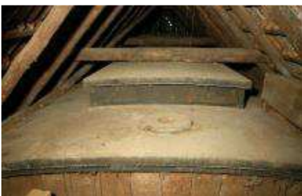
Ausicht auf das Dach
