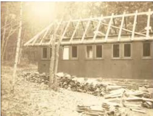
Waggon 4 noch ohne Holzverschalung und ohne Anbau. Foto: Loheland – Archiv Nr. FB-A-712-41
