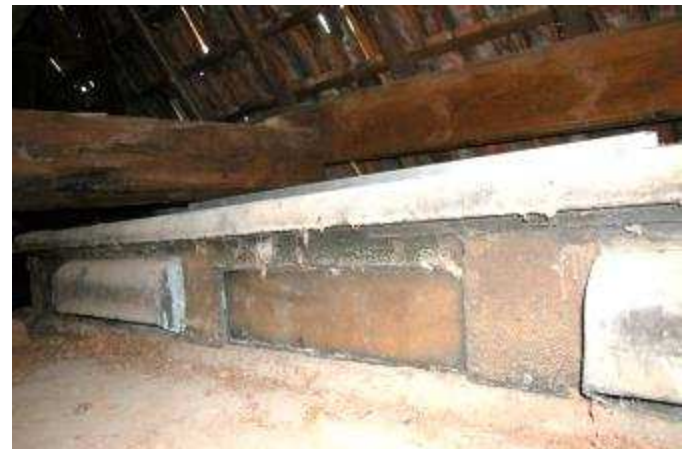
Deutlicher Abstand zwischen Lufthutzen und Fenstern.
