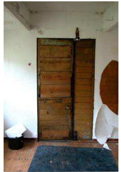
Tür in den Anbau mit Original-Aufschrift.
