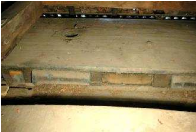
Oberlicht mit Lüftungsöffnung im Dach. Im Vordergrund die Dachkante des Waggon 4.
