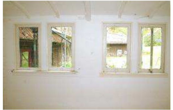
Vier erhaltene Schiebefenster im vorderen Teil auf der Südseite.
